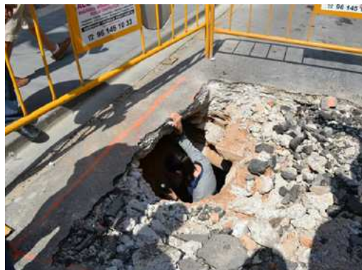
Detall de l'entrada localitzada durant les obres.
