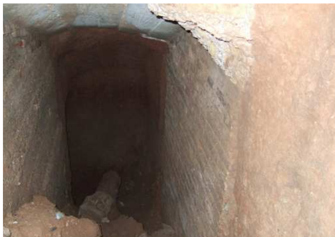
Figura 11.- Detall de l'entrada al refugi de la Plaça Pinzon on s'aprecia com part de l'accés estava fet amb rajoles (Fotografia: Pep Chiner).
