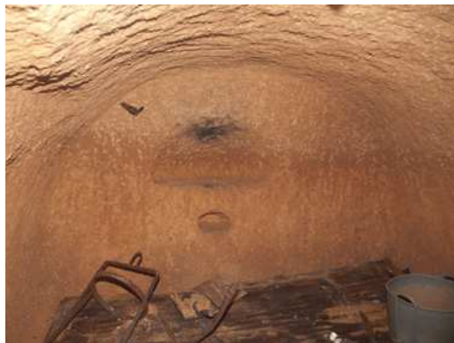
Sostre de volta amb fornícules excavades a la paret.
