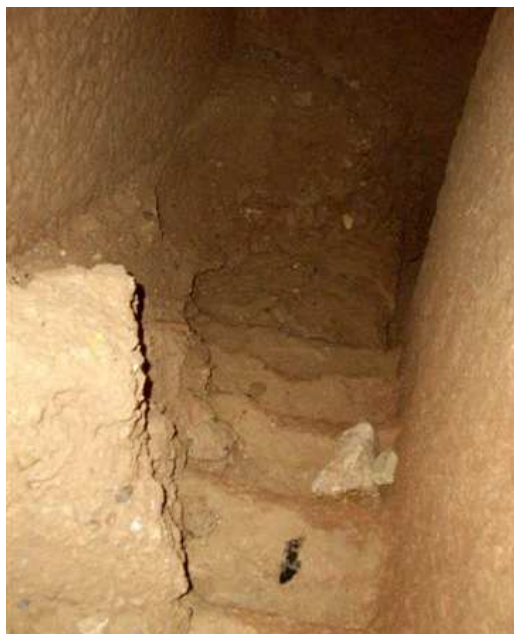
Detalls dels esglaons de l'escala d'accés.
