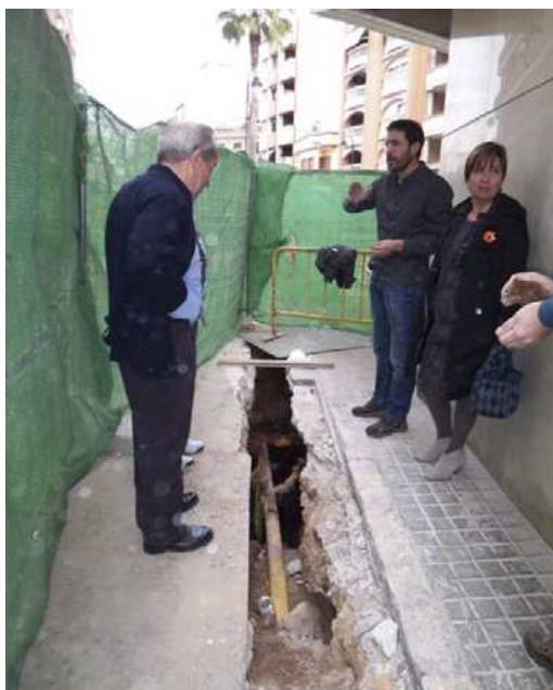
Personal municipal inspeccionant la boca d'entrada.
