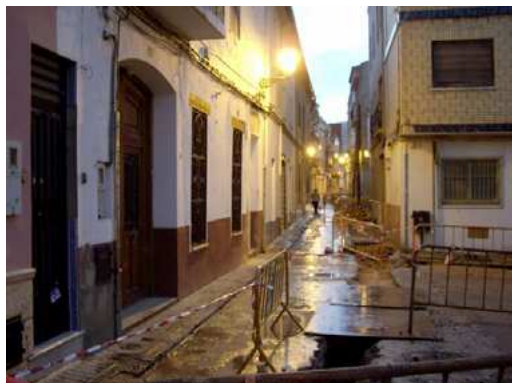
Carrer L'Alcota i plaça en obres.
