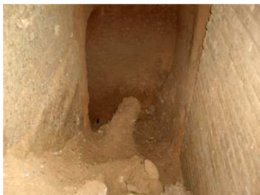
Rampa d'accés al refugi amb parets de rajola.
