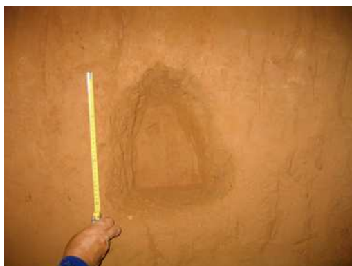
Detall d'una fornícula excavada a la paret.
