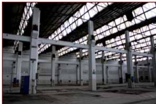
Factoría Elcano. Armaduras Shed del taller de motores
