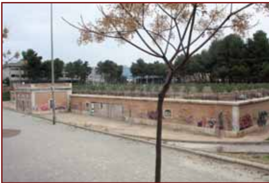
Depósito de Aguas Potables de Valencia
