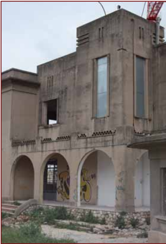
Edificio de oficinas de la factoría Refracta, actualmente en rehabilitación
