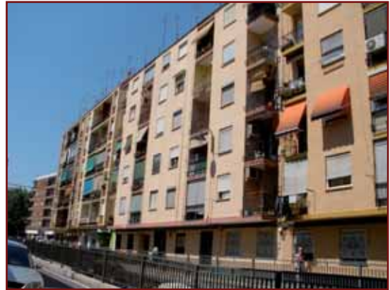
Calle Barranquet, edificaciones tipo de los años 60, 70 y 80
