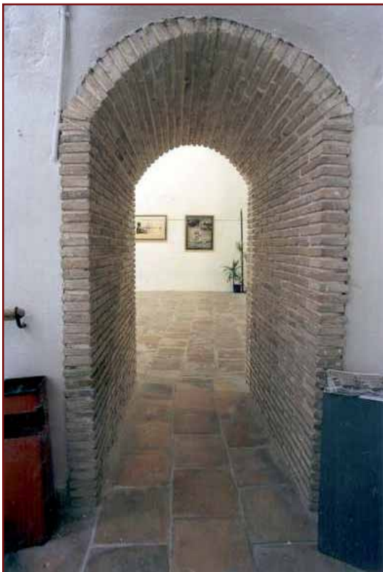
Detalle del interior de la Cisterna de Quart de Poblet. Fuente: Ayuntamiento de Quart de Poblet
