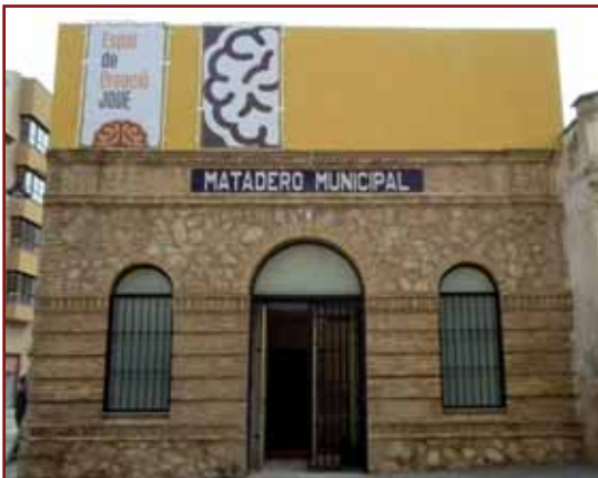
Antiguo Matadero Municipal, recientemente rehabilitado
