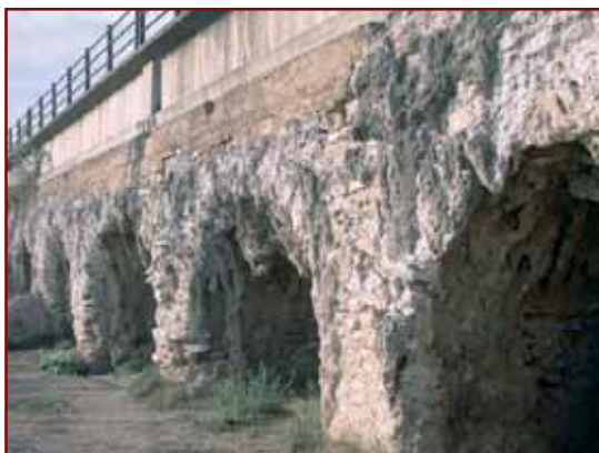
Acueducto dels Arcs de Manises, mediante el cual la acequia de Quart atraviesa el barranco del Salt de l'Aigua. Detalle de las estalactitas
