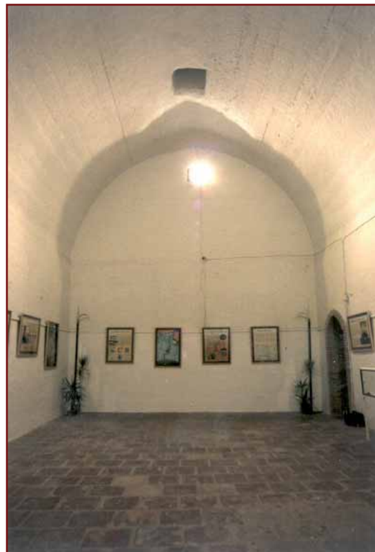
Cisterna andalusí que se llenaba una vez al año mediante el braç del Molí. Se aprecia la bóveda de ladrillo, encalada como es tradicional, y la apertura superior para introducir el cubo y sacar el agua
