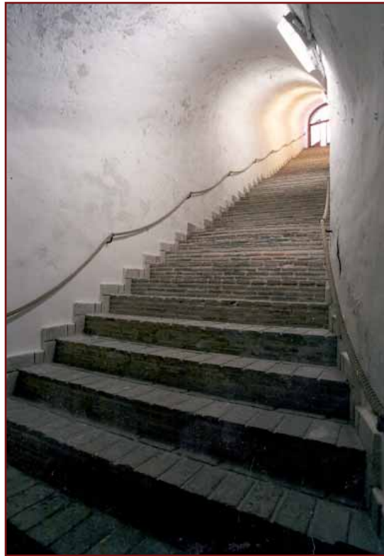
Detalle del interior de la Cisterna de Quart de Poblet. Fuente: Ayuntamiento de Quart de Poblet
